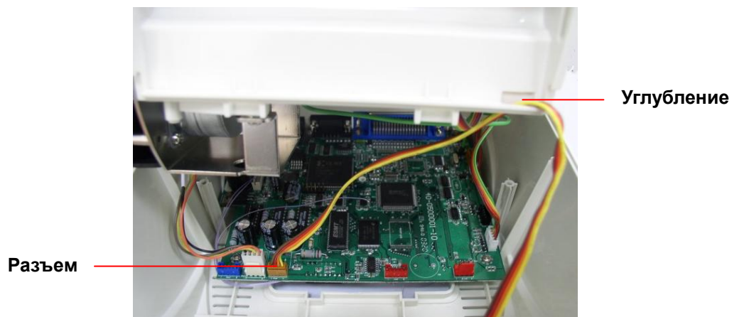
Рис. 16. Прокладка жгута проводов модуля резака
